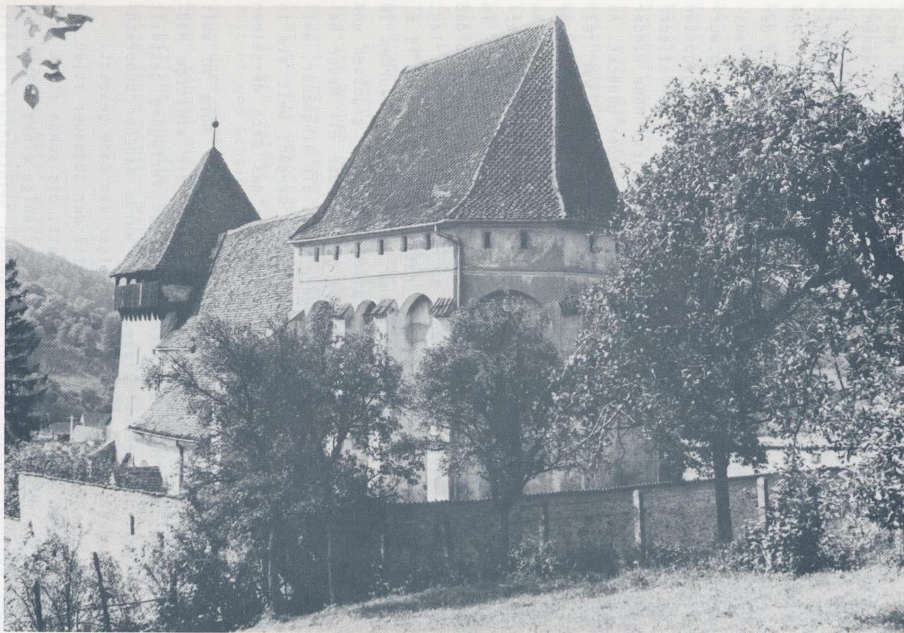
Südostansicht der Kirchenburg
